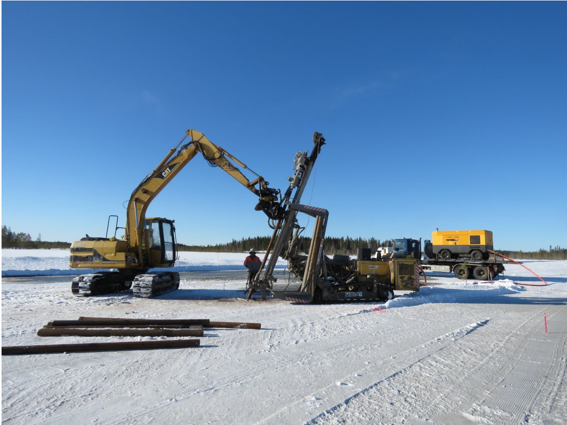
Kuva 3-6. Porapaaluperustuksen tekoa suoalueella, jossa työalue on jäädytetty.
