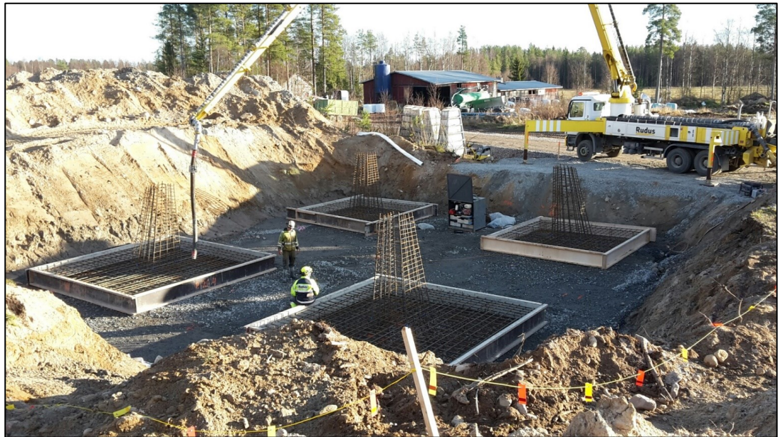
Kuva 3-5. Vapaasti seisovan pylvään perustuksen pohjatöitä.
